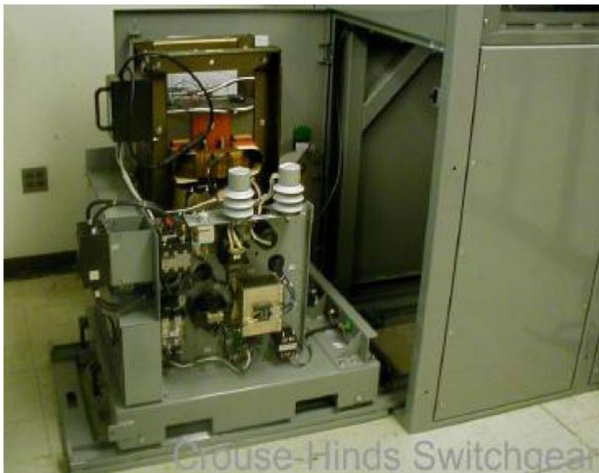
Regulador de Corriente Constante fuera del nicho inferior.
