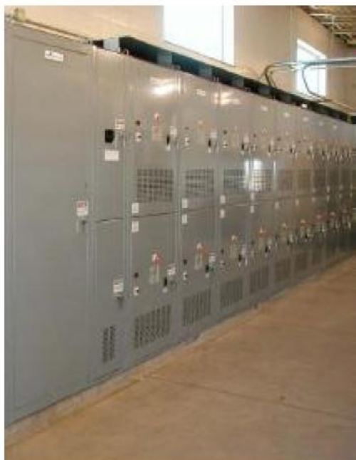
Reguladores de Corriente Constante tipo Ferroresonante hasta 30kW en Gabinete Switchgear, en dos niveles.
