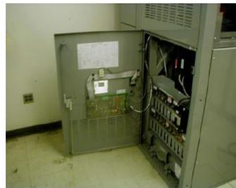
Regulador de Corriente Constante dentro del nicho inferior.
