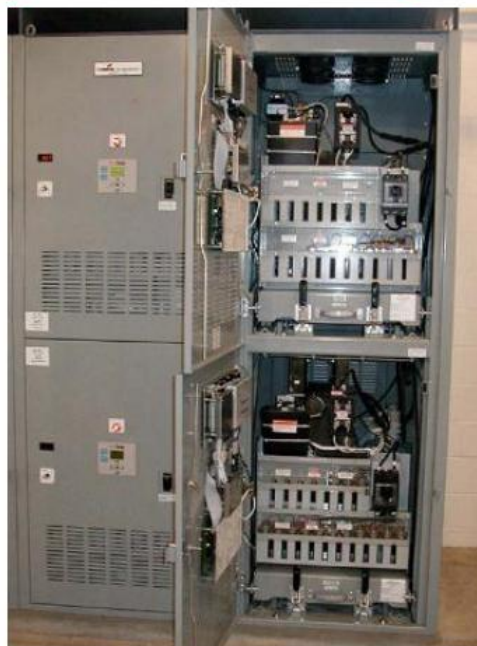
Reguladores de Corriente Constante tipo Ferroresonante hasta 30kW en Gabinete Switchgear, en dos niveles.
